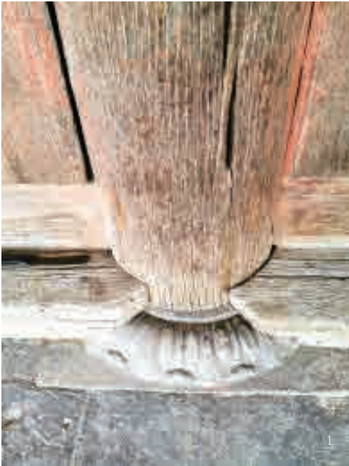
1 2 3 4 1, 覆盆莲花柱础; 2, 佛光寺东大殿剖面图, 梁思成绘制;
